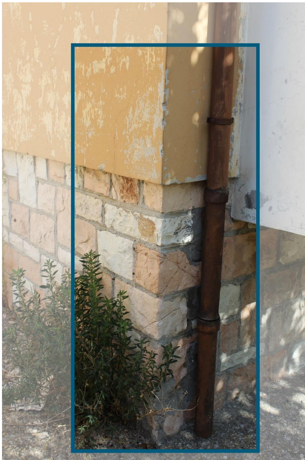
15) Lesione da schiacciamento derivante da cedimenti fondali.
