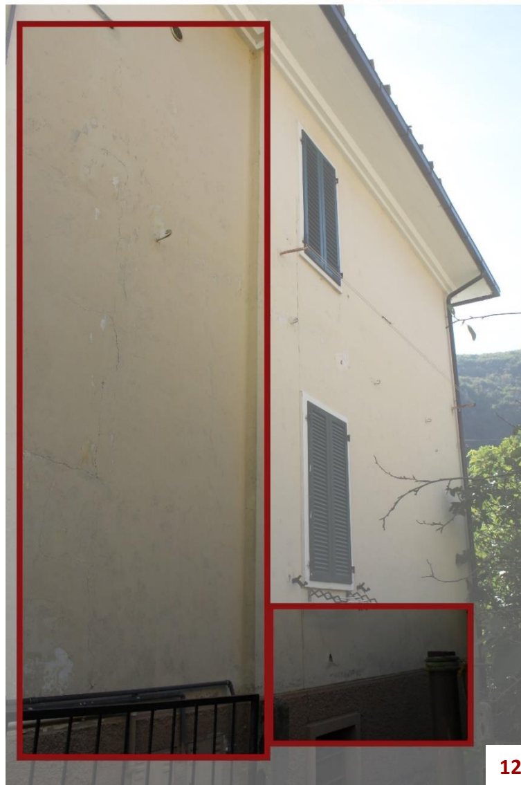
11-12) Umidità di risalita dal terreno e umidità di condensa con ammaloramento dell'intonaco.
