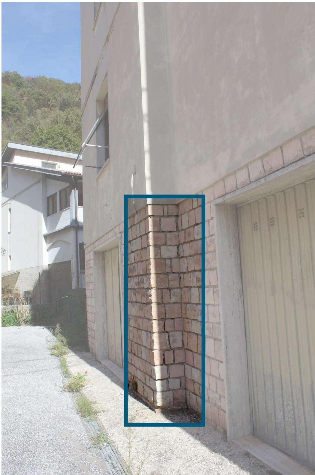
11) Lesione da schiacciamento derivante da cedimenti fondali combinata con l'azione sismica.
