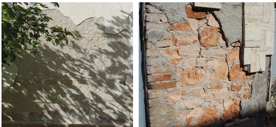
Figura 2.5: Muratura a scaglia rossa intonacata.
