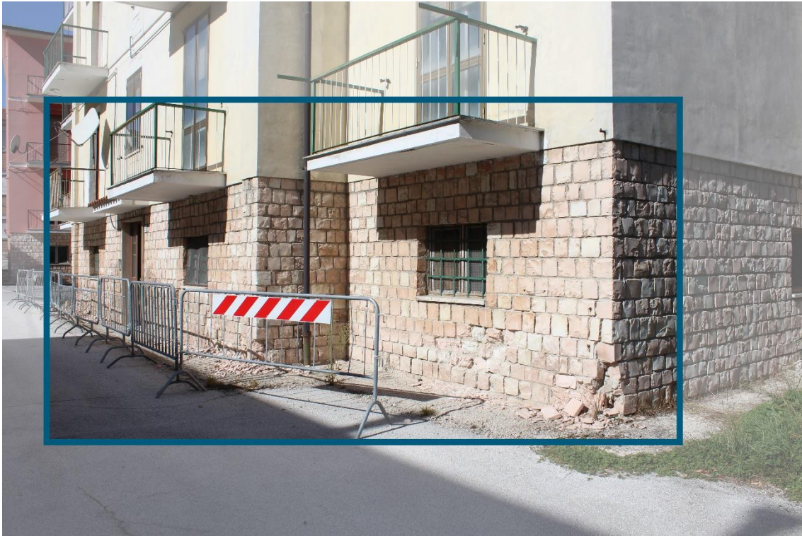
7) Lesione da schiacciamento derivante da cedimenti fondali combinata con l'azione sismica.
