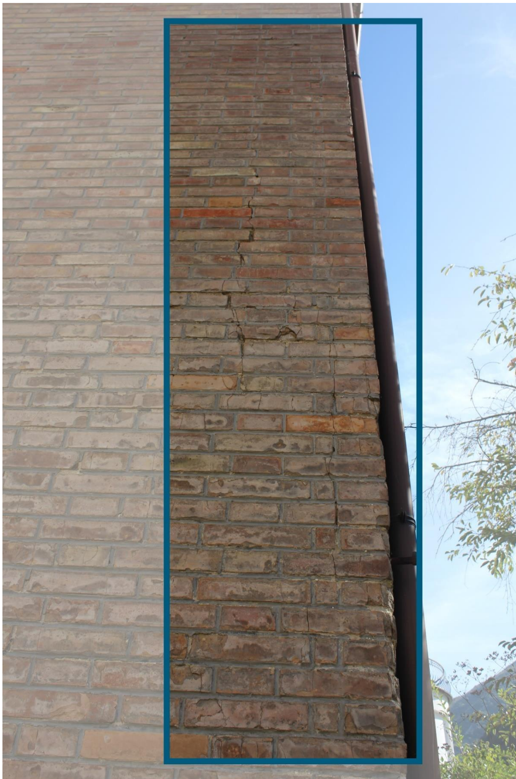
6) Lesione da schiacciamento derivante da cedimenti fondali.
