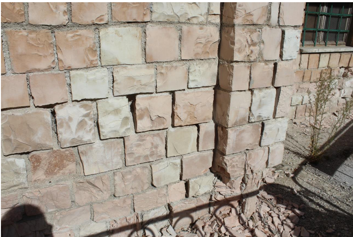
8) Lesione da schiacciamento derivante da cedimenti fondali combinata con l'azione sismica.
