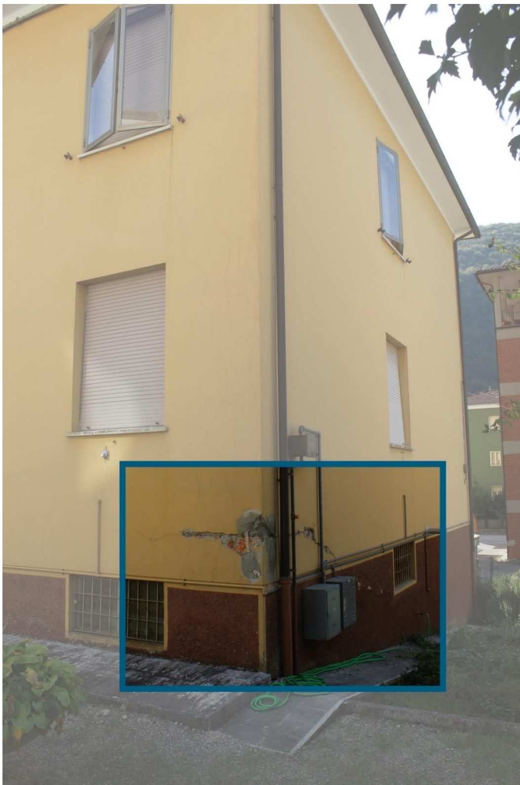
1) Lesione da traslazione orizzontale trasversale.
