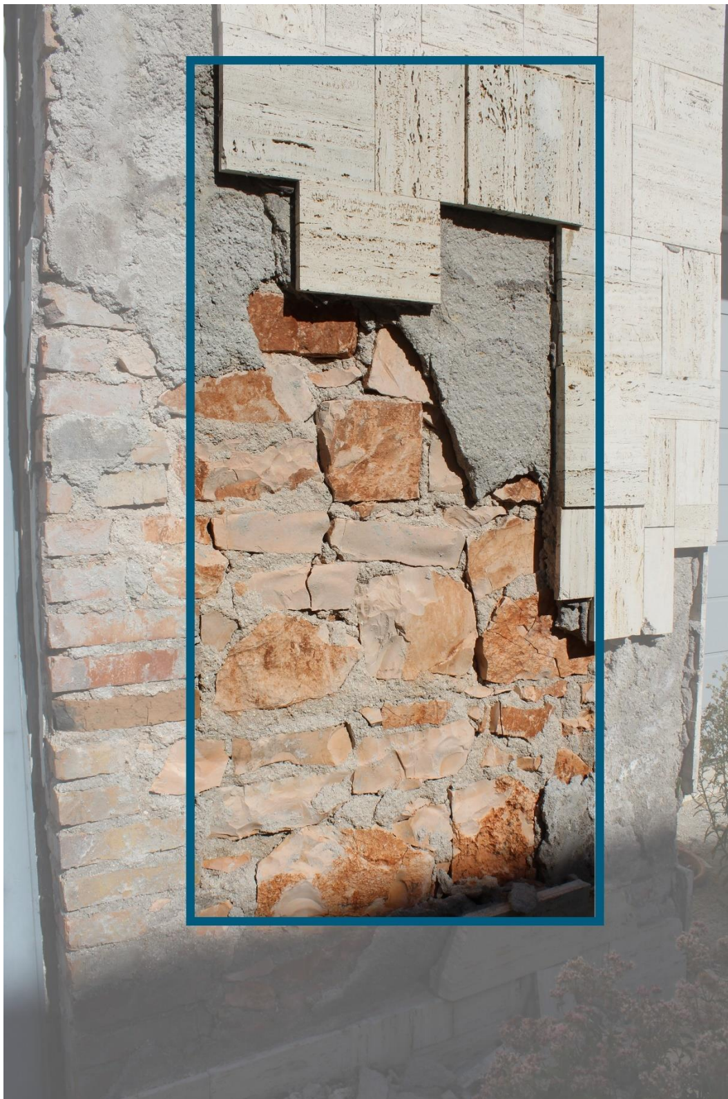
21) Lesione da schiacciamento derivante da cedimenti fondali combinata con l'azione sismica.
