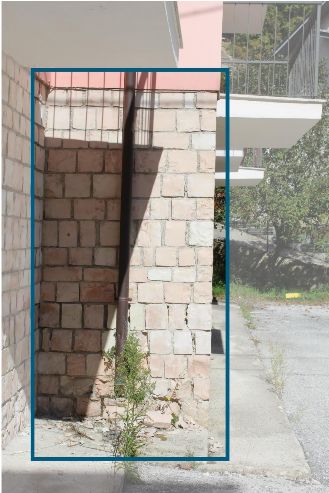
5) Lesione da schiacciamento derivante da cedimenti fondali combinata con l'azione sismica.
