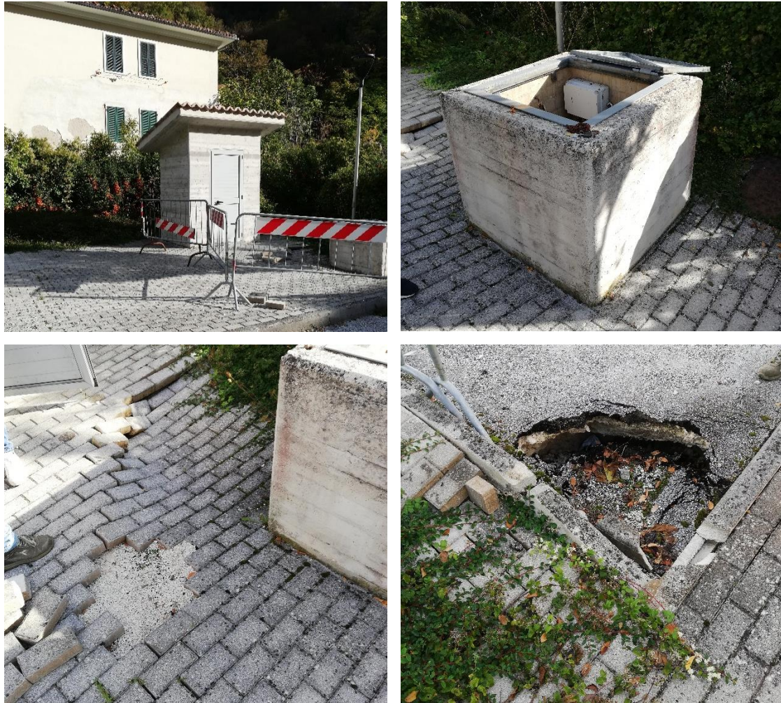
Figura 1.11: Manufatti del sistema di alimentazione della falda e abbassamento della sede stradale.
