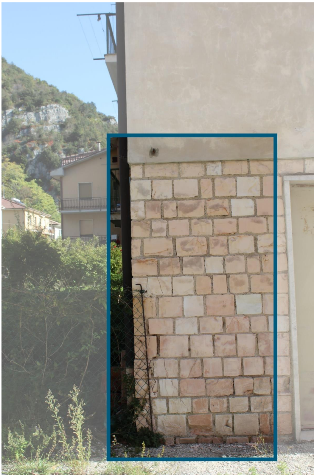
12) Lesione da schiacciamento derivante da cedimenti fondali combinata con l'azione sismica.
