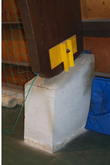
FOTO 1 – Plinto in c.a. fuori terra
