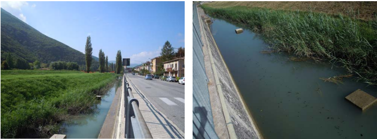
Figura 2: Il collettore presente all'interno del canale “COLLETTORE”
