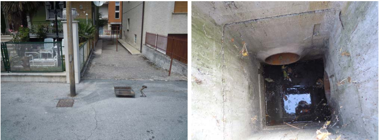
Figura 5: Pozzetti fognari all'innesto di Via Aldo Vincenzetti con Viale Raffaello Sanzio
