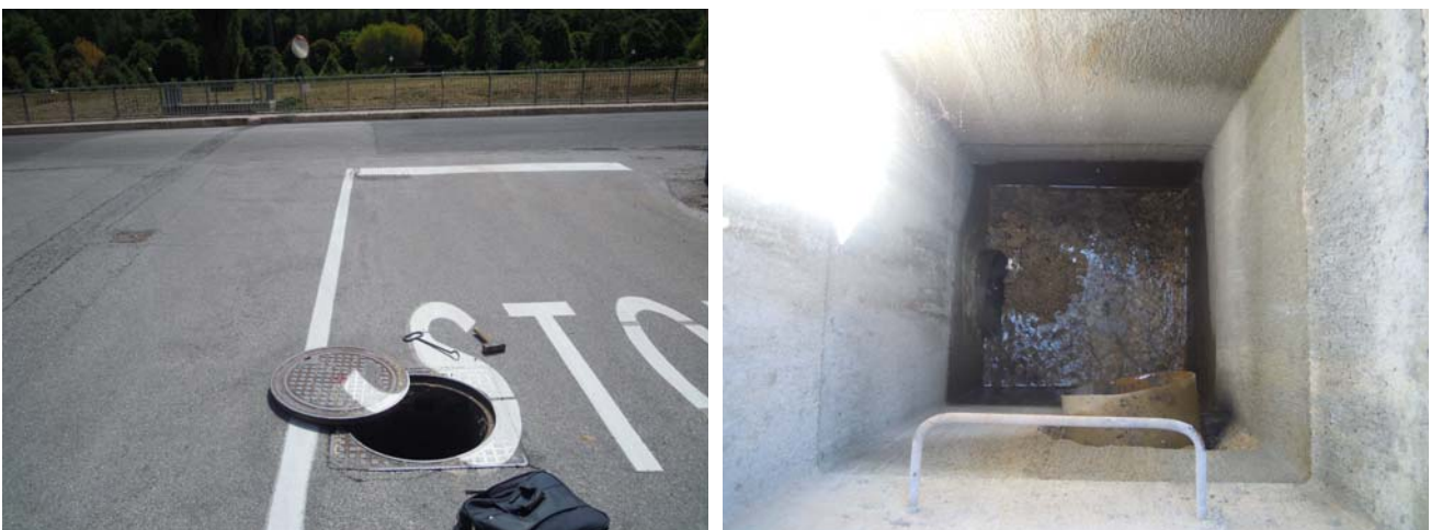
Figura 4: Pozzetti fognari all'innesto di Via Aldo Vincenzetti con Viale Raffaello Sanzio
