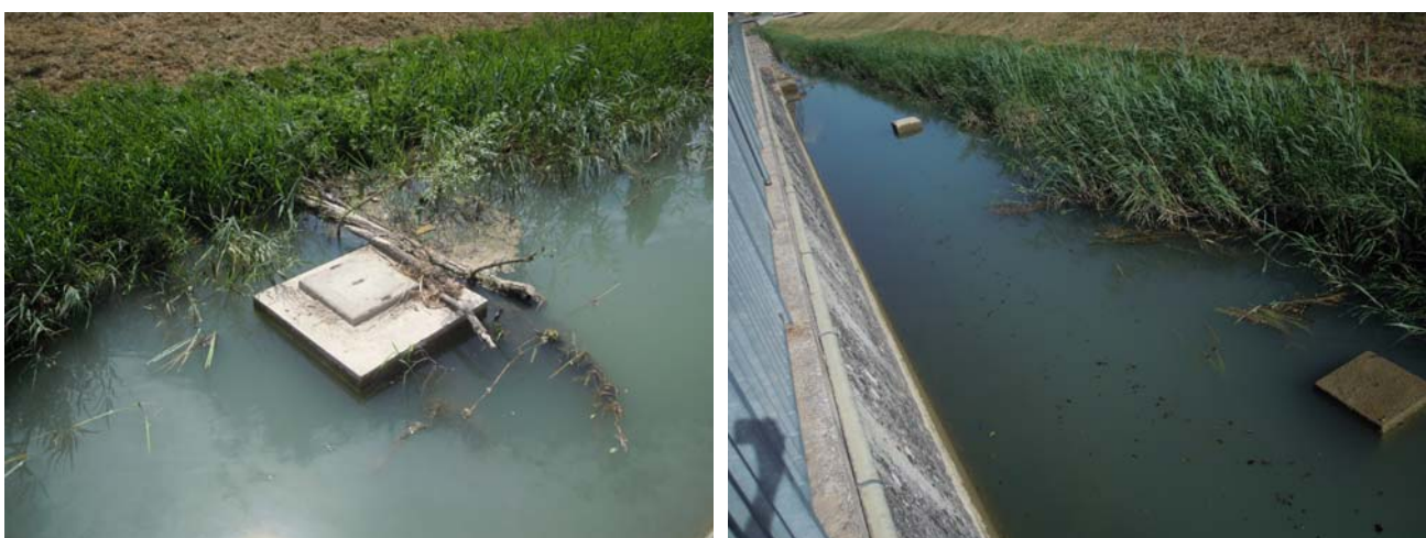
Figura 2: Collettore fognario posto nel Canale Collettore
